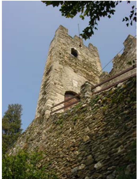
La torre d'ingresso vista dall'esterno
